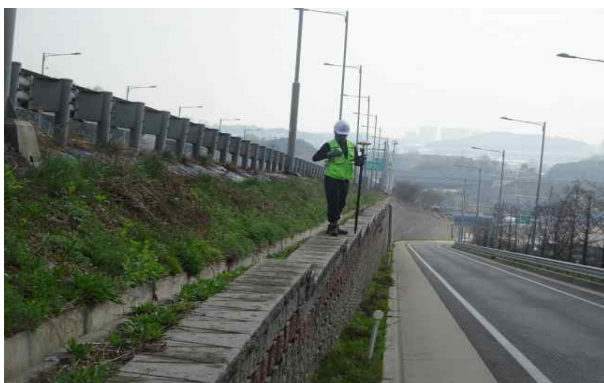
c. 측정분할 전경
